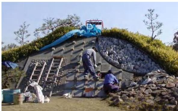
片岡くずしの庭…踏み荒らしの激しい芝生斜面は、大磯の種石(3分)で洗い出し仕上げに改修。
